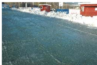
Figur 7 Smelting av brøytekanter og tungt regn ga overvann som frøs.
